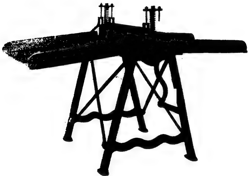
Рис. 11. Льномялка Делера (двухвальная).
